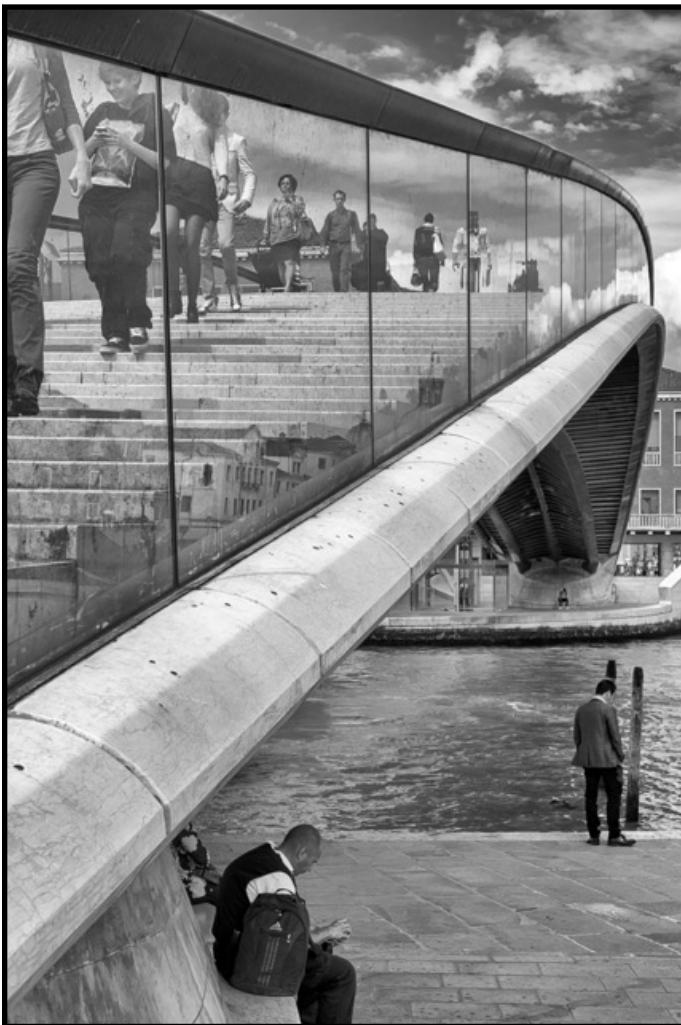
General Division Image of the Night "Ponte della Costituzione, Venice" by Theo Goodwin
